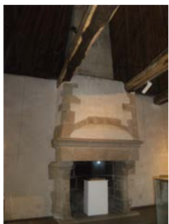
Cheminée de la tour sud-ouest
